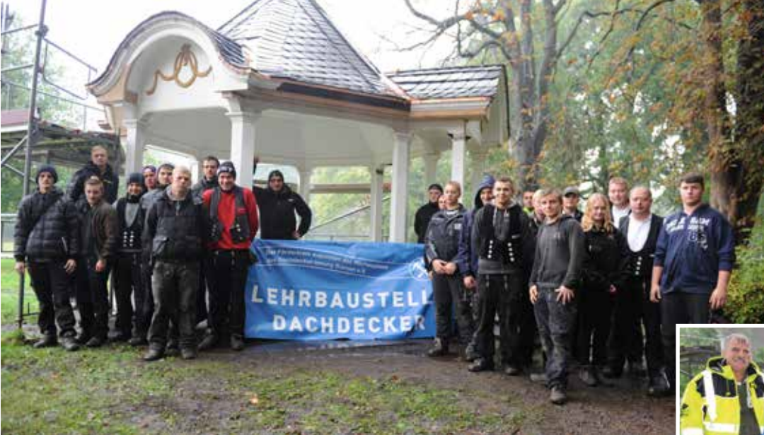
■ Stolz auf ihre Leistung: Dachdecker-Auszubildende, die Gerdes-Pavillon und Betriebshof neu gedeckt haben. Angeleitet durch Dachdeckermeister Michael Haarde (2.v.r.)
