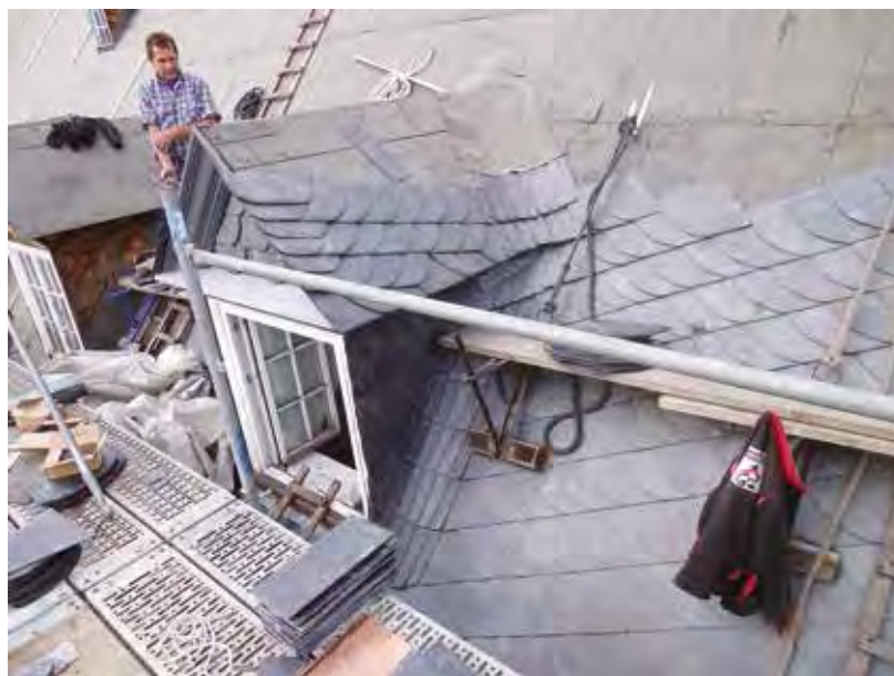
■ Eine besondere Herausforderung: die 80 Dachgauben.
