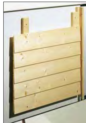
■ Ob Deckelschalung (l.) oder Stülpschalung (r.), bauen mit Holz steht für zahlreiche Varianten und Profile, die nicht nur optische Vielfalt bieten, sondern gleichzeitig eine gesunde Wärmedämmung ermöglichen.
