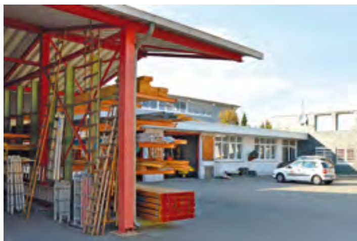
■ Die "Dach-Manufaktur" am Bodensee.
