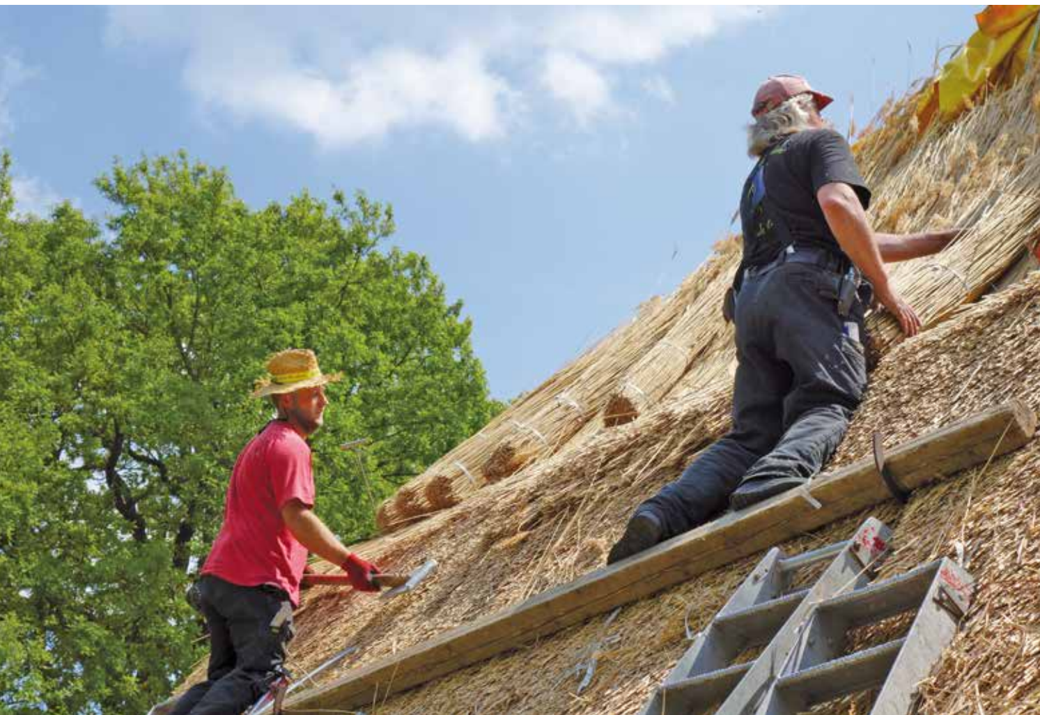
■ Immer mit auf dem Dach: Bruder Reimer Ohm (rechts).
