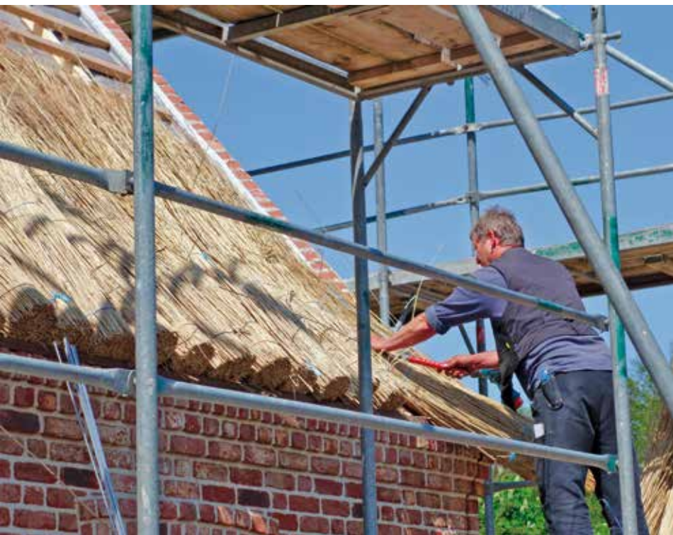
■ Die Reetballen werden von unten nach oben auf dem Dach ausgelegt.
