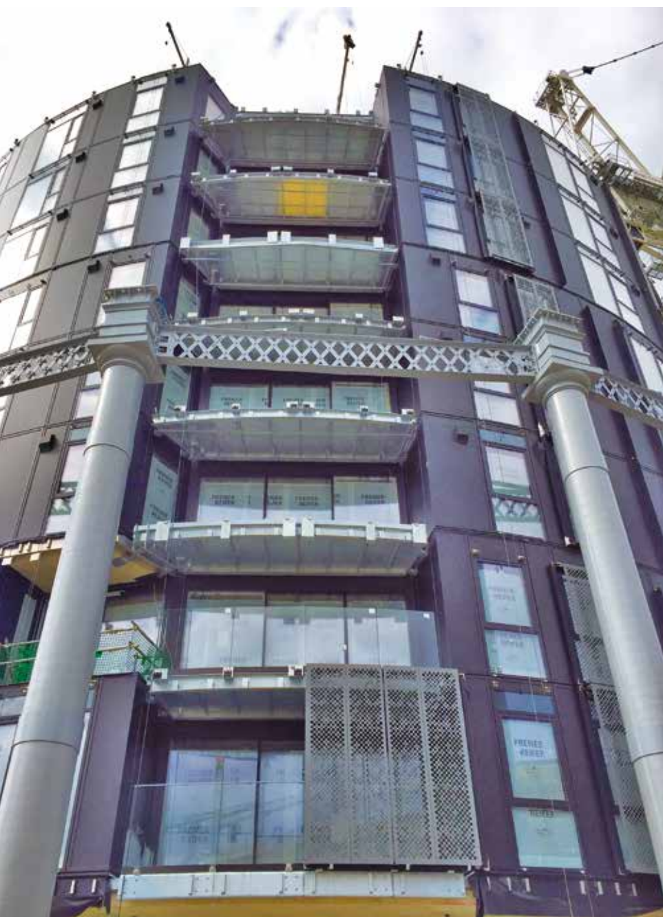
■ Hochwertiger Wohnungsbau im Londoner Quartier Kings Cross. Sperber führt die Abdichtung der Balkone und die Montage der Fallrohre aus.
