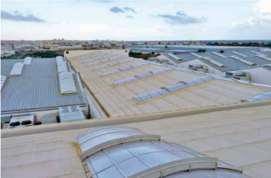
■ Flachdächer gibt es auch in Tunesien: Eine aktuelle Baustelle von Sperber in Sousse.
