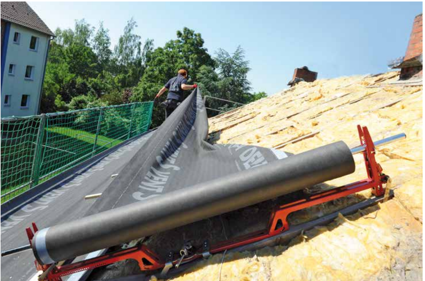
■ Die neue Hilfe beim Verlegen.
