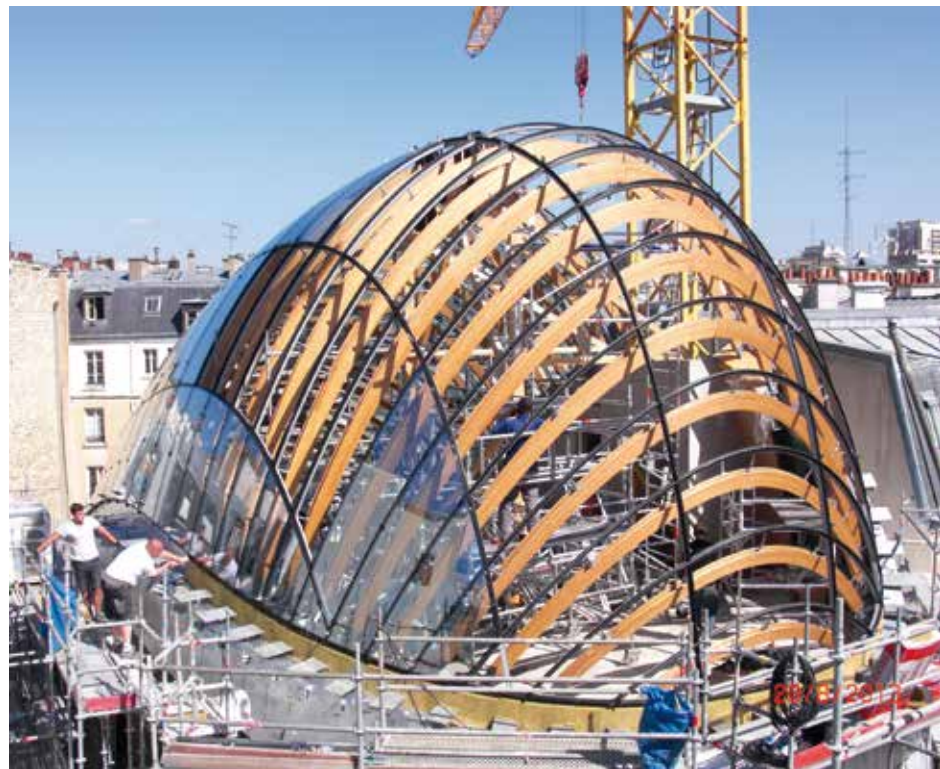
■ Spektakulärer Neubau der Pathé-Stiftung für Filmliebhaber. Sperber führte die Arbeiten an der Glasdach-Kuppel aus, die 25 Meter über die Mansardendächer der umliegenden Häuser hinauswächst.
