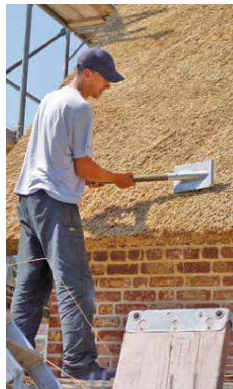
■ Das Reet wird geklopft, bis es flächig und dicht liegt.
