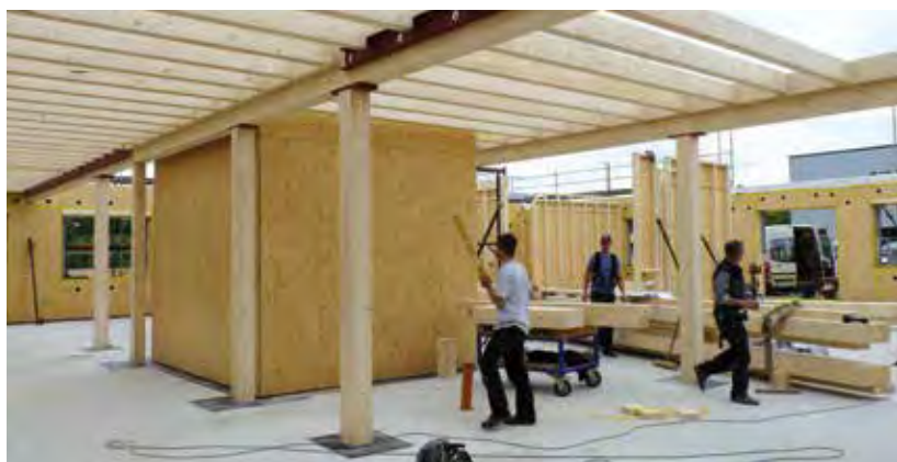
Klassischer Holzrahmenbau ist neben dem Denkmalschutz eines der weiteren Geschäftsfelder des Betriebs.
