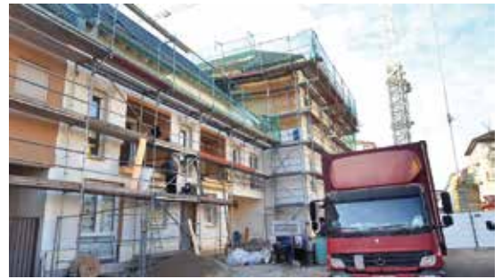
Nach nur fünf Monaten Bauzeit für den Holzbau wurde Richtfest gefeiert.
