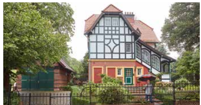
Strom- und Wasserversorgungszentrale Meierhofstraße in Bremen-Nord
