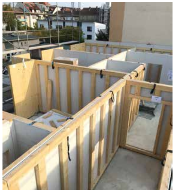
„Wachstumspotenzial“: So schnell werden fünf Etagen mit den vorgefertigten Wandelementen hochgezogen.
