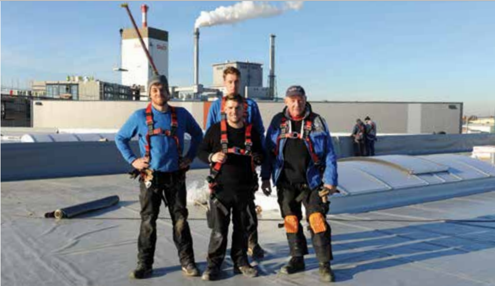
Die Mitarbeiterteams ziehen mit, auf dem Dach und in ganz Deutschland.
