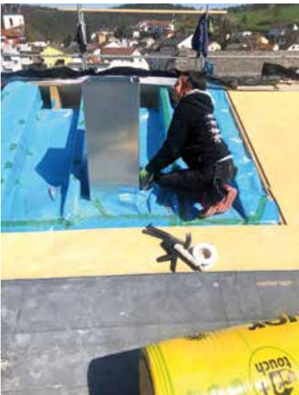
Abdichtungsarbeiten an der Abdeckung für den Aufzugschacht, der gleichzeitig zur Entlüftung dient.
