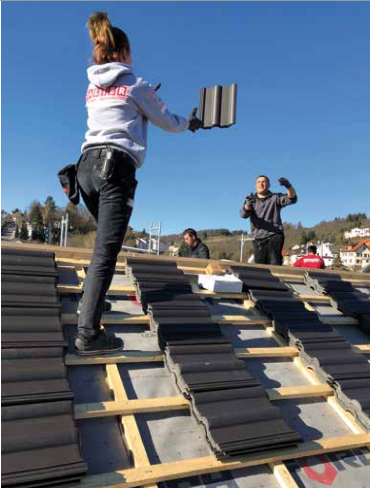
Ziegelwerfen in luftiger Höhe – auch ein Teil der täglichen Arbeit
