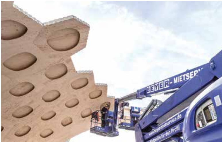
Die Schale wurde im freien Vorbau aufgebaut.
