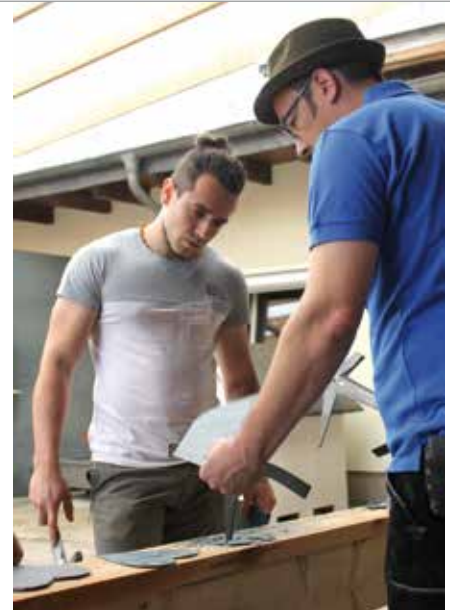
Schieferarbeiten erfordern handwerkliches Geschick.
