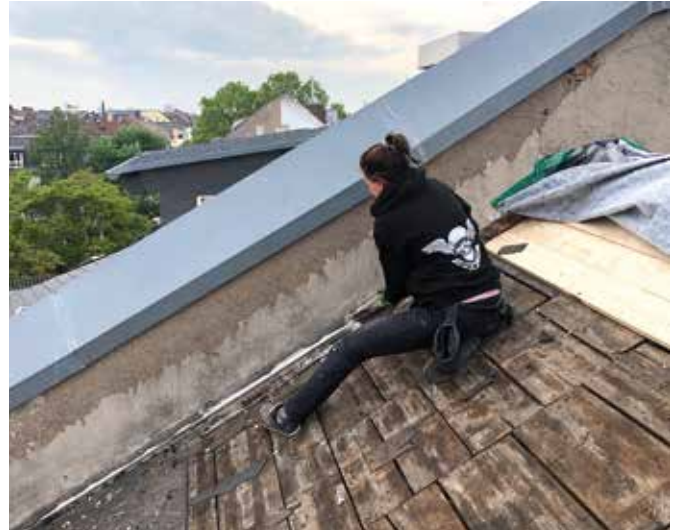
Vorbereitende Arbeit für die Dachsanierung
