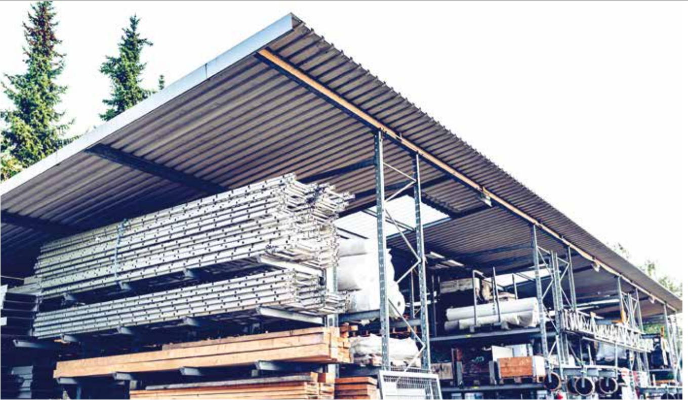
Das Dach des Außenlagers wird demnächst per Solartechnik zu einem weiteren Energielieferanten.
