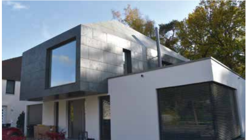
Fassade, Dach und Untersicht der Auskragung wurden komplett in Schiefer ausgeführt.
