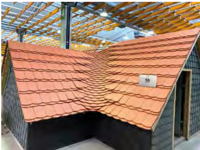
Julia Peetz hat als Meisterprojekt eine Biberschwanz-Kronendeckung mit eingebundener Kehle gedeckt, zwei Ziegel breit in 4er Teilung.
