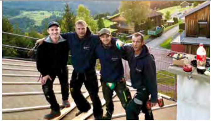
Tolle Arbeit, toller Ausblick: Gute Laune beim Steildachteam (links: Jonas Küpper) bei einer Dachsanierung im Jahr 2019.
