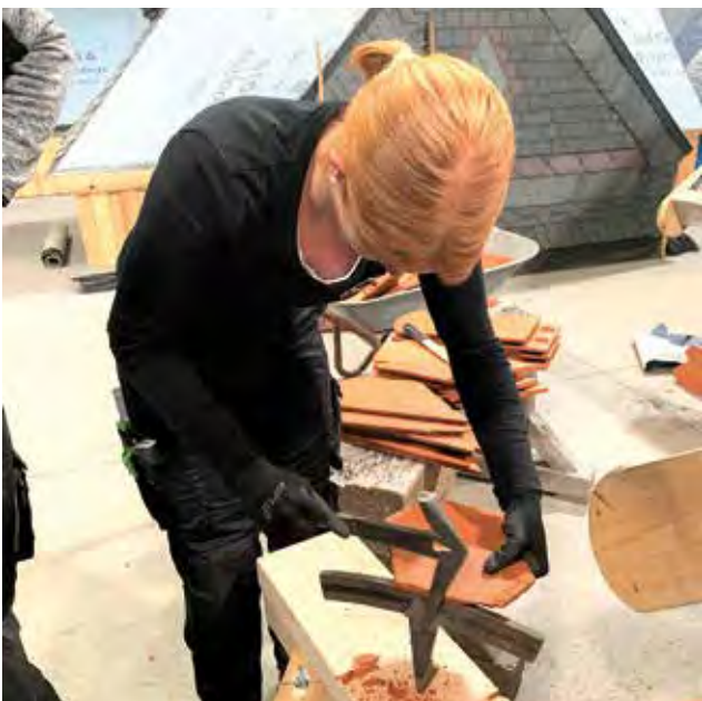
Vorarbeiten für das Dachmodell: Zuschneiden der Dachziegel
