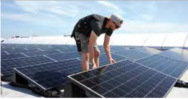
Solarelemente der „Solar Fabrik“. Sichere Befestigung der Elemente ist gewährleistet. Die Module sind mittels eines Bajonetts auf dem Grundfuß verankert.
