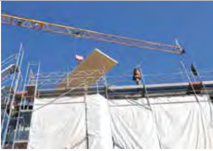
Herausforderung Logistik: Mal über die Fußgängerzone, mal über den Innenhof des Dom Hotels hob der Kran die schweren Wand- und Deckenelemente hinauf auf das Dach.
