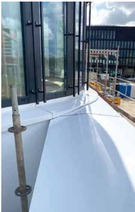
Beim Fraunhofer Institut verbaute Henke die Fassade so, dass die Kanten des Baus durch gerundete Alucobond Platten versteckt werden, das Ergebnis: Kein einziger 90 Grad Winkel
