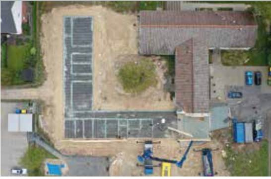
Was wären Dachdeckerbetriebe heutzutage ohne Drohnen? Diese Bilder demonstrieren eindrücklich den Baufortschritt in Neustadt.
