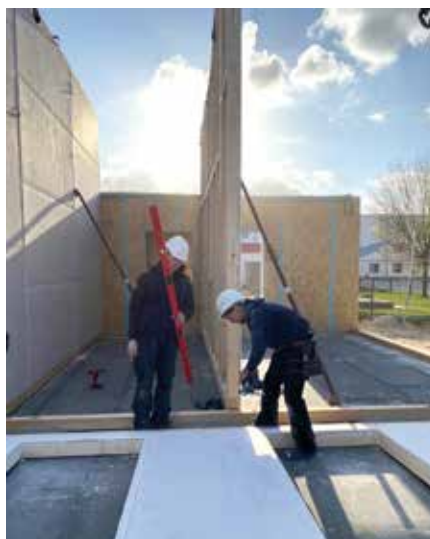
Vorbereitung für die Montage: Die extern vorgefertigten Holzrahmenbauwände.
