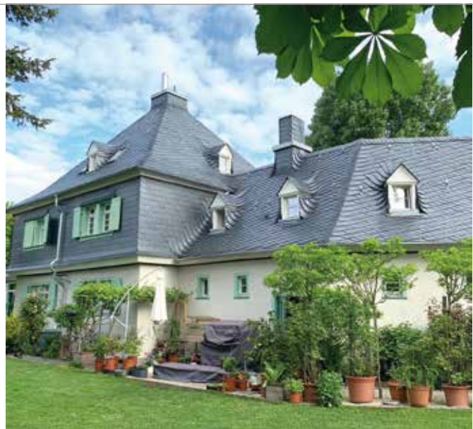
Einer der exklusivsten Aufträge für Reiner-Dach war die historische Himmelsbachsiedlung in Bingen.
