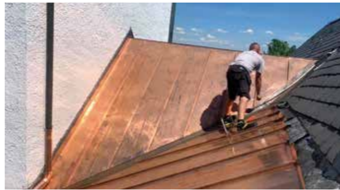
Anspruchsvolle Klempnerarbeiten zählen zu den Stärken des Betriebs.
