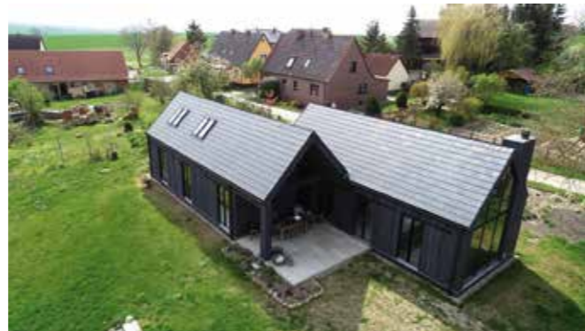
Das Ferienhaus von Marius Bell und Kasia Swiezak (Foto links) greift mit seiner Architektur die Form traditioneller Scheunen in der Umgebung auf. Die Dacheindeckung unterstreicht dabei mit ihrem klaren Fugenbild den modern-reduzierten Charakter des Gebäudes.
