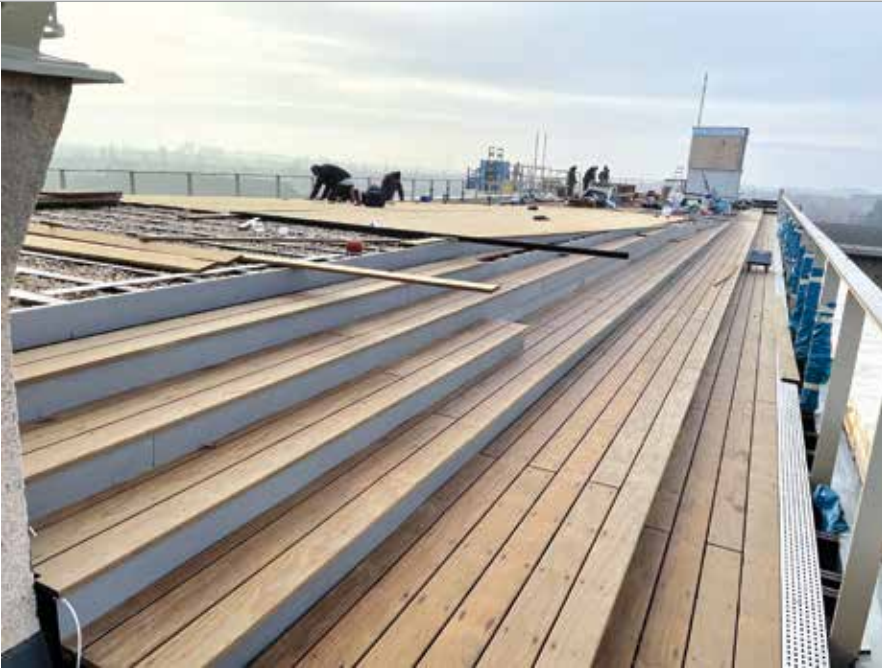
Über den Dächern von Berlin realisierten die Mitarbeiter von Poburski die Besucherplattform für den Flughafen-Tower.
