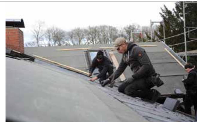
Auszubildende arbeiten eigenständig auf einer Lehrbaustelle im Bremer Bürgerpark.
