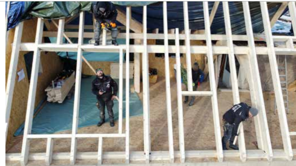
Florian Wilhelmy (unten links) mit seinem Team auf der Baustelle.
