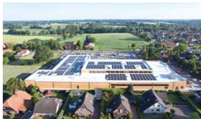
Flachdach nach Fertigstellung mit Folie, Dämmung und Dampfsperre. Für die Energiebeschaffung sorgt eine Photovoltaikanlage.
