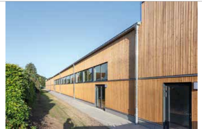
Fenster und Türen wurden fachgerecht mit eingebaut.
