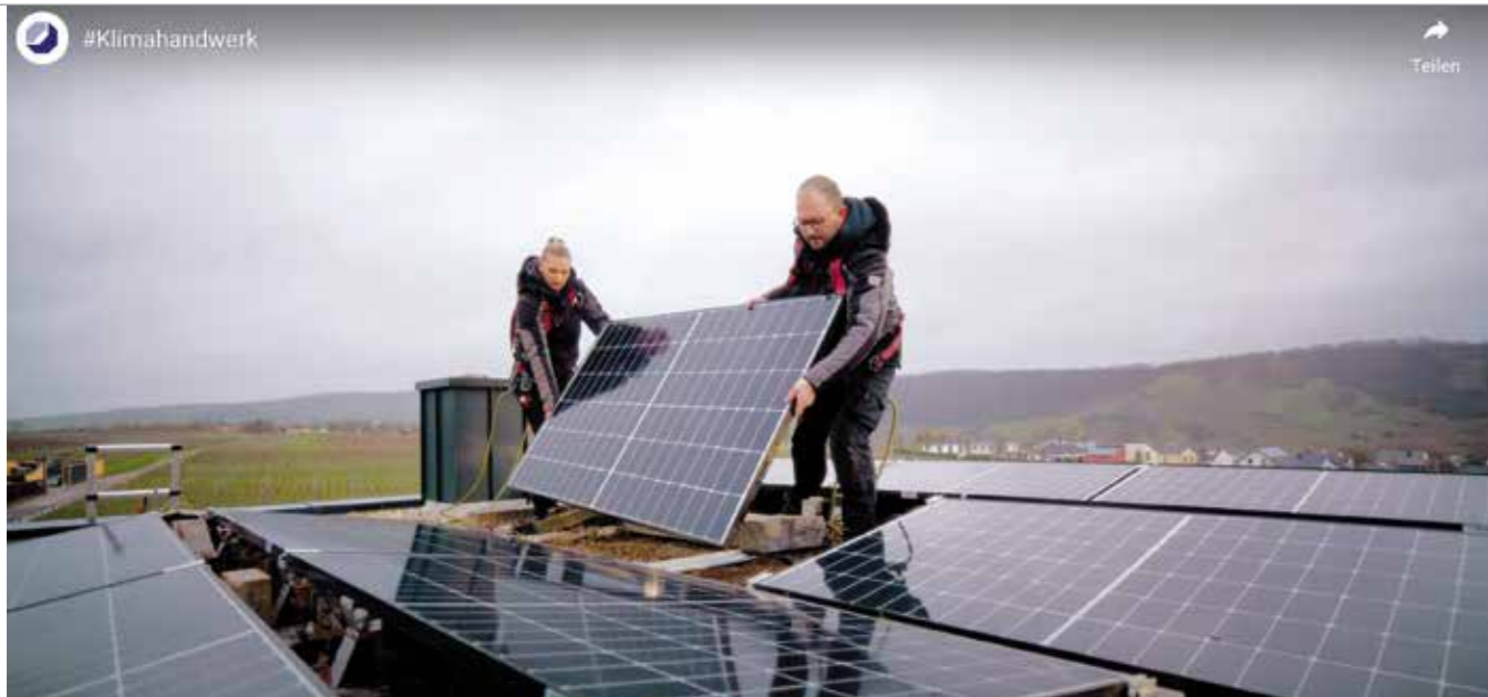
Imagefilm Klimahandwerk: Miriam Dorny und ihr Chef Michael Ludes installieren eine PV-Anlage.
