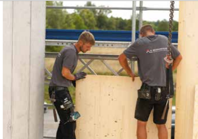
Die Holzkonstruktion errichtete das Team Weißenberger in Massivbauweise.
