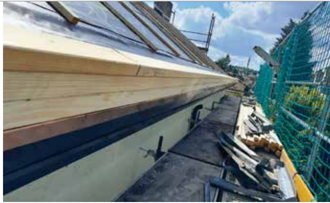
Licht und Ausblick im Dachgeschoss schaffen sechs neue Velux Schwingfenster aus Kunststoff in unterschiedlichen Größen.
