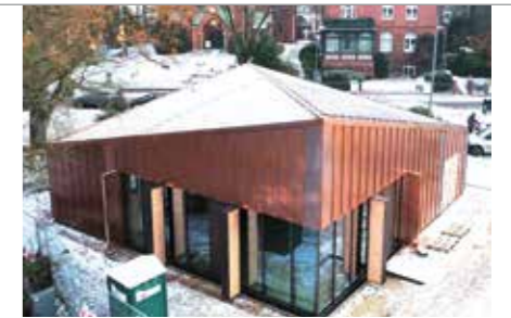
Das neue Markthaus – Bestandteil des Marktplatzes in Blankenese.
