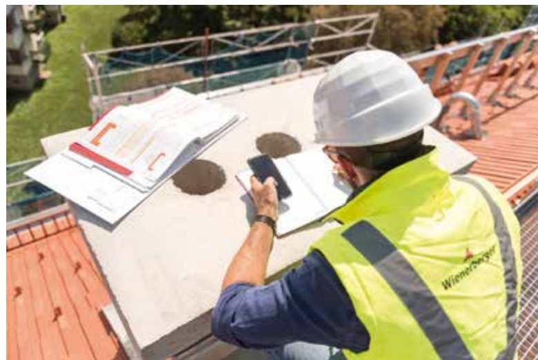
Wienerberger-Mitarbeiter auf dem Steildach.
