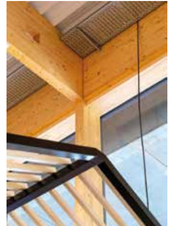
Detailansicht der tragenden Holzkonstruktion.
