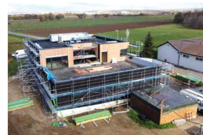
Die Baustelle aus Drohnensicht: „Gerade bei der EPDM-Dachbahn war die Vorkonfektionierung und Verlegung anspruchsvoll“, sagt Geschäftsführer Manuel Weißenberger.
