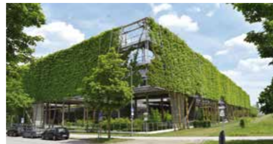
Optische Aufwertung: ansprechende Fassadenbegrünung für ein Parkhaus
