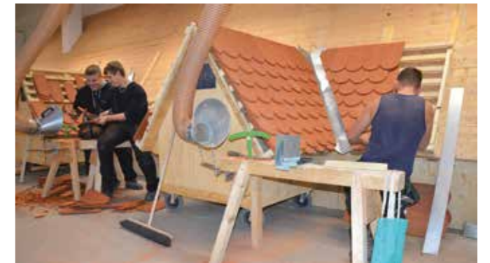
Arbeiten am klassischen Steildachmodell mit Biberschwanzziegeln.
