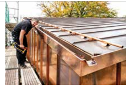
Aufgrund des starken Gefälles wurde eine extrem tiefe innenliegende Rinne eingebaut.
