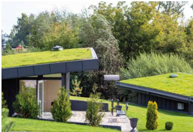
Auch ein Gründach kann Teil der Förderung für ein Effizienzhaus 40 sein.
