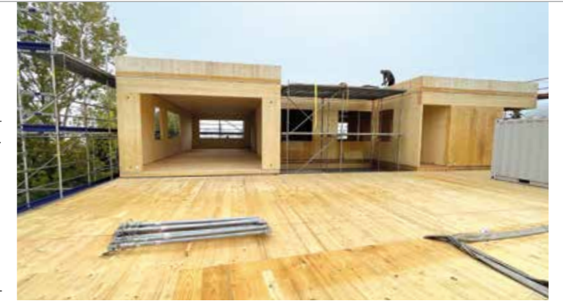
Holzarbeiten am Obergeschoss des Gebäudes.
