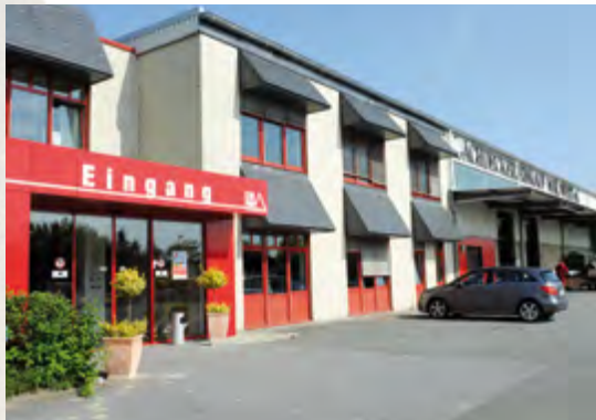
Dachdecker-Einkauf Nordwest eG, Weyhe
