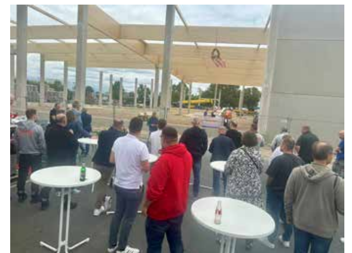
Mitglieder, Kunden und Mitarbeitende feierten Ende August den Baufortschritt mit dem Richtfest.
