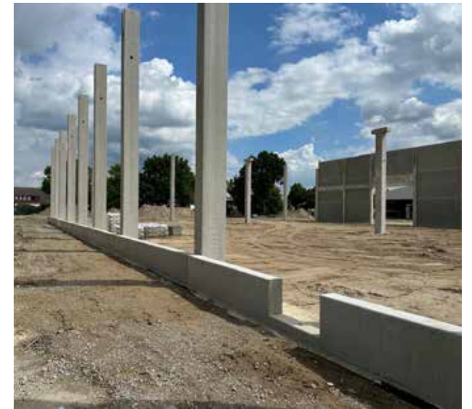
Baufortschritt am Standort Weyhe: Die neue Lagerhalle nimmt Gestalt an.
