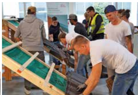
■ Auszubildende beim Eindecken der Dachfläche.
