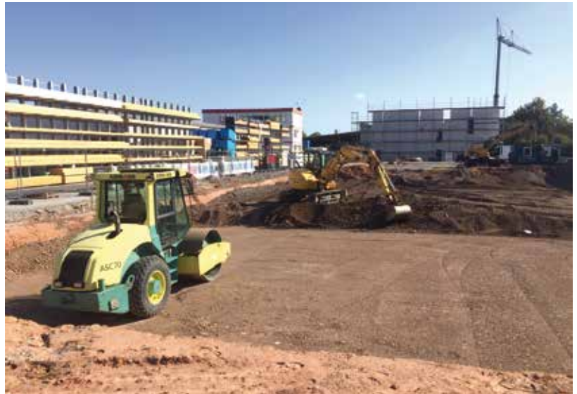
In Dietzenbach entsteht auf über 12.000 qm eine neue DE Süd-Niederlassung. Dabei bleiben alle Gebäude (hier links) bis zum Neubezug stehen, um das Tagesgeschäft aufrechtzuerhalten.
