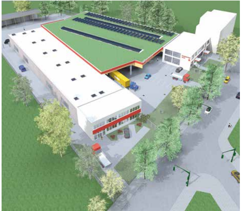
■ Optimale Betriebsbedingungen wird das neue Gebäude der Niederlassung Berlin-Lichterfelde bieten.
