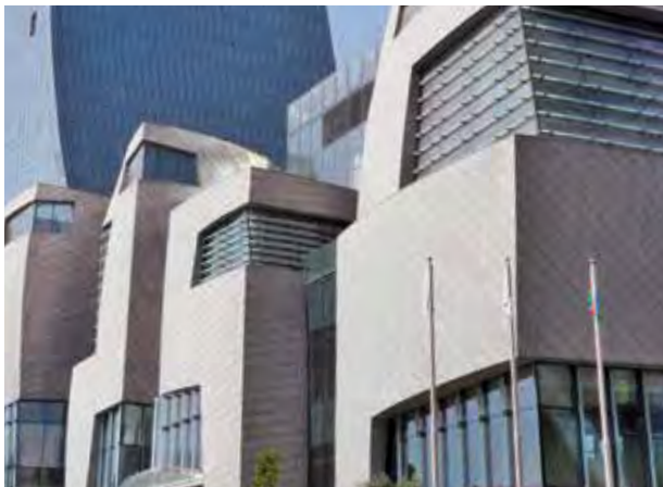
■ Am Bau der Flame Towers in Baku, der Hauptstadt Aserbaidschans, war Böhme Systems 2012 beteiligt.
