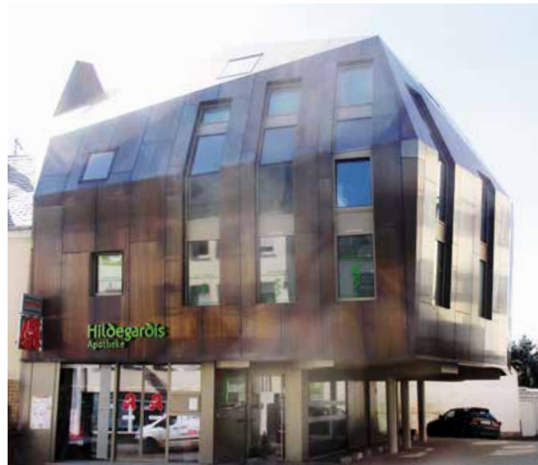
■ Dach und Fassade wurden mit Tecu-Bond 4 mm in Oxid-Farben verkleidet.
