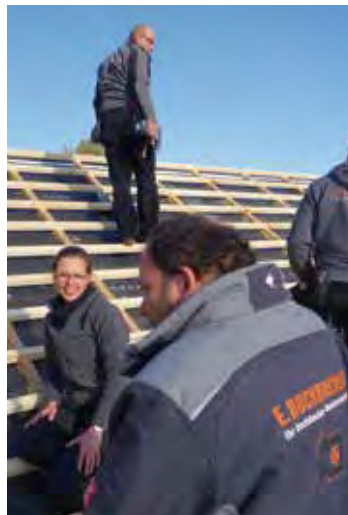
Kurze Besprechung auf dem Dach mit dem angestellten Dachdeckermeister Olaf Panter sowie am Telefon im Büro.
