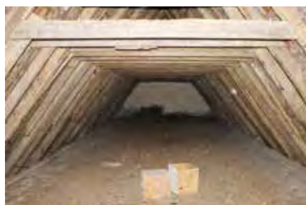
Alte Eichensparren und neuere Weichholzsparren im Wechsel
