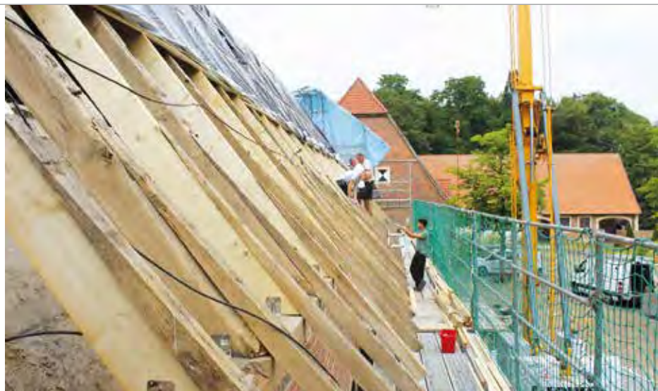
Alte Eichensparren und neuere Weichholzsparren im Wechsel
