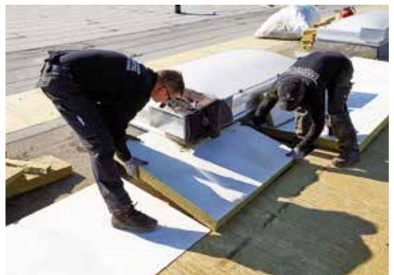
Am Anfang der Arbeiten stand die Demontage der gerade einmal 40 bis 50 mm dicken Dämmung aus Polystyrol und einer an manchen Stellen fast gleich dicken Abdichtung aus Bitumenbahnen.
