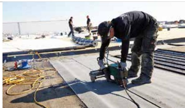
Dann ging es an die Dämmung. „Um die künftige Entwässerung der großen Dachflächen zuverlässig sicherstellen zu können, haben wir uns für ein nicht brennbares Gefälledachdämmsystem entschieden, im Einklang mit der aktuellen Verkaufsstättenverordnung und den Vorgaben des Bauherrn komplett in A1 Brandschutzqualität“, so Projektleiter Klein.
