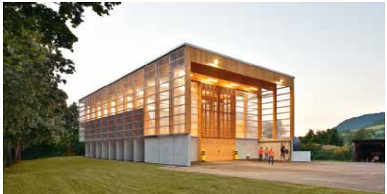
Da sich durch eine geänderte Logistik im Streusalzvertrieb die Anforderungen an die Schütt- und Einfahrtshöhe (zehn Meter) von Salzlagerrhallen geändert haben, wurde ein neuer Gebäudetypus entwickelt. Die gewählte Konstruktion minimiert die Anzahl aufwändiger und schadensanfälliger Metallverbindungen. Wo sie nicht vermeidbar sind, lassen sie sich jederzeit kontrollieren und ohne großen Aufwand warten.
