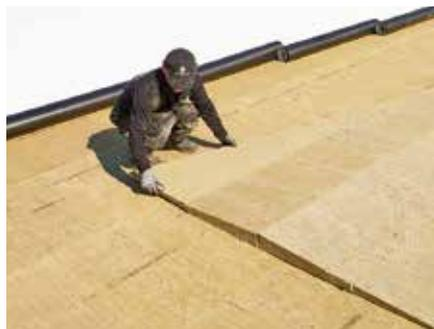
Als erste Dämmlage dient eine 90 mm dicke Grunddämmung aus Durock 037 Platten.
