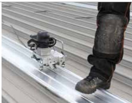
Die Bördelmaschine ist speziell von Kalzip für diese Verlegearbeit konstruiert worden.
