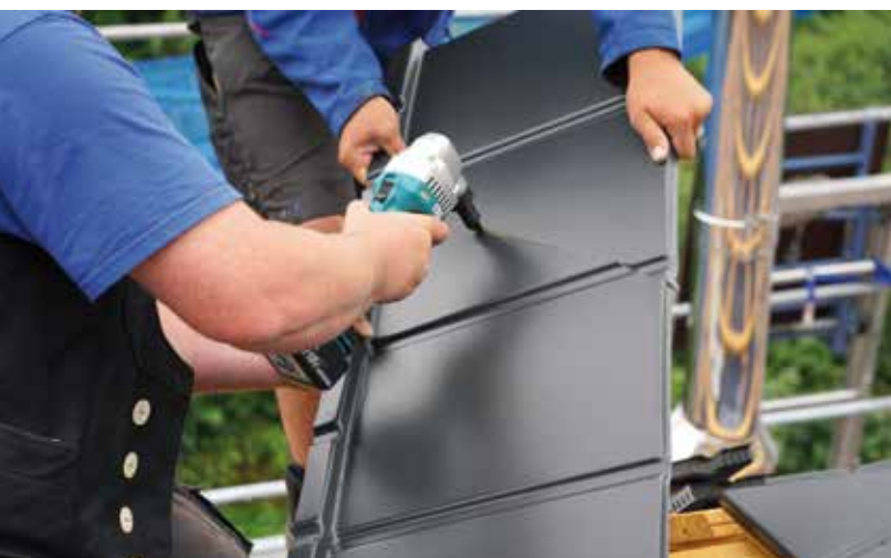
Powertekk Plano kann man sehr einfach und vielfältig für Detailausbildungen zuschneiden. Angefangen von Blechscheren, Handkreissägen oder wie in diesem Fall mit einem Nibbler.
