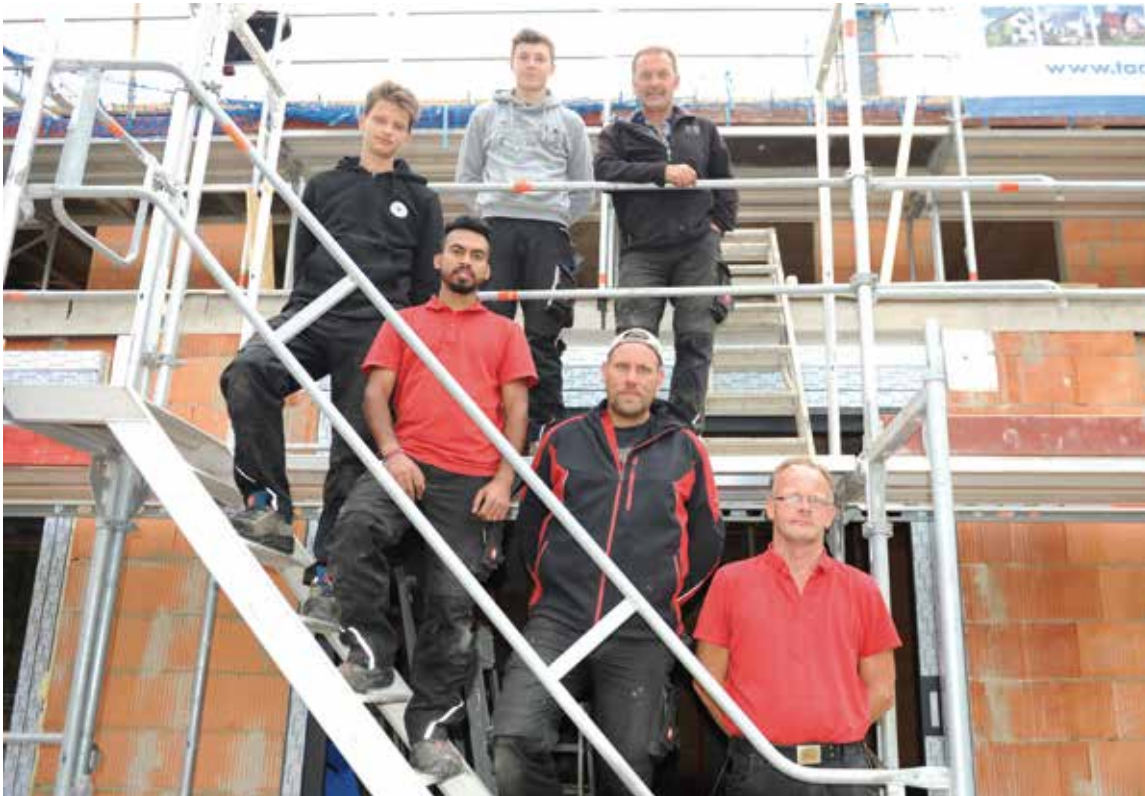
Gelungene Integration: Vakar Arif (2.v.l.) mit seinen Kollegen bei einem Neubau- projekt
