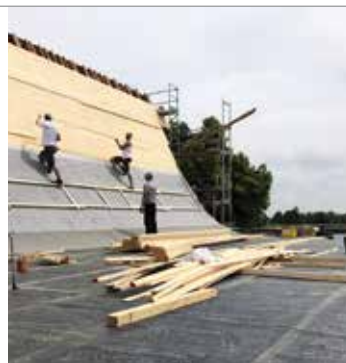
Der Dachstuhl wird von verzogenen Holzbalken getragen.
