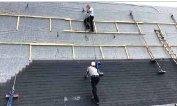
Sechs Wochen dauerte die Dachsanierung – drei bis vier Mitarbeiter waren jeweils täglich vor Ort.
