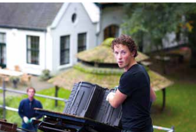
Kraft und Ausdauer sind gefragt auf dem Dach.
