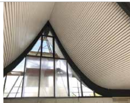
Der Holzbau stellte bei der Dachsanierung die erste große Herausforderung dar.
