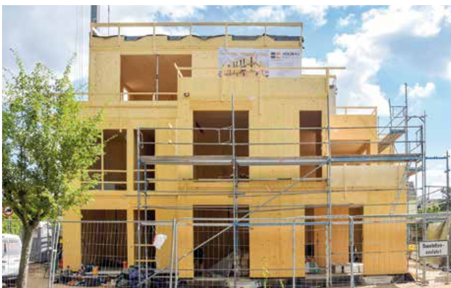
Das Zweifamilienhaus in Holzbauweise nimmt Gestalt an.
