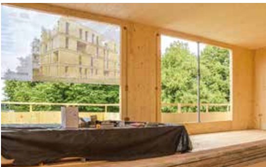
Holz schafft innen ein gutes Raumklima und dank dünnerer Wände auch mehr Platz.
