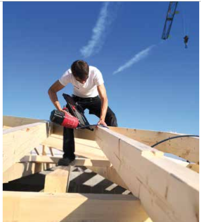
Florian Brönnecke steht auch selbst mit auf dem Dach.
