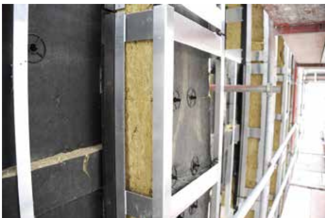
Auf den Millimeter genau passend lässt Stallkamp sich die Pfeilverkleidungen produzieren; das spart Zeit auf der Baustelle und die Trespa-Platten können maßgerecht bestellt werden.
