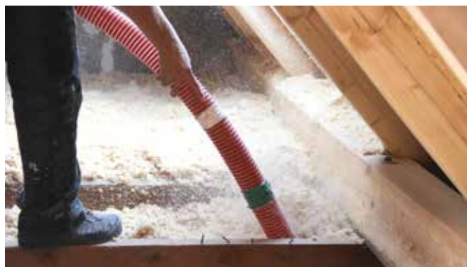
Brönnecke dämmt ausschließlich ökologisch, vorwiegend mit Holzfaser- oder Cellulose-Einblasdämmung.
