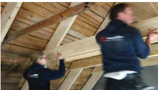
Dachstuhl sanieren in Fischerhude: Katja Wiesenmüller und ein Kollege ziehen massive Holzbalken ein.
