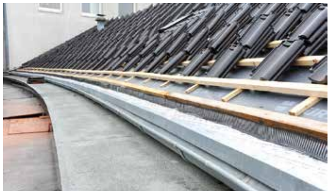
Die Deckung für die Innenrundung erweist sich immer einfacher als für die Außenrundung.
