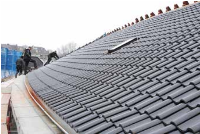
Firma Brandes sorgt für gleichmäßige Deckung und Entwässerung in der Kurve.
