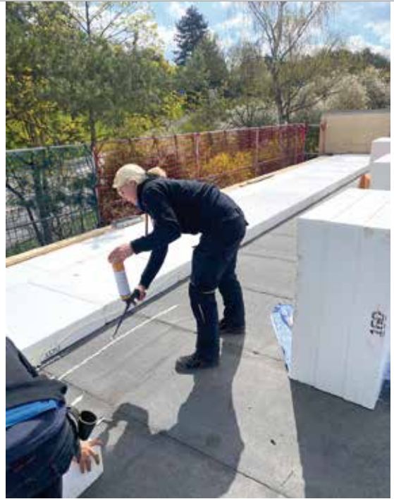
Packt gerne an auf den Baustellen: Vanessa Thieltges.
