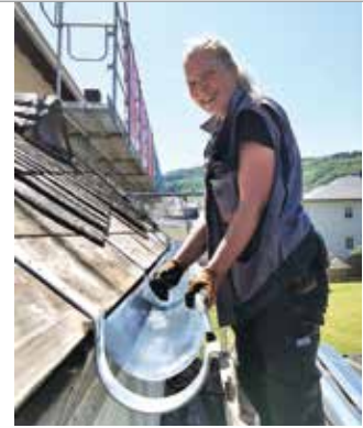
Dachdeckermeisterin und Schiefer-spezialistin: Miriam Dorny leitete die Baustelle.
