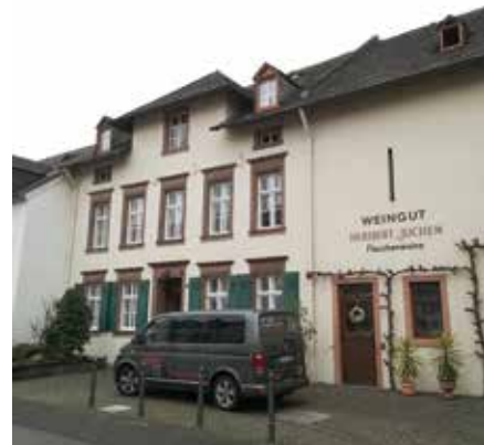
Das Originaldach des Weinguts Heribert Jochem von 1905 war in die Jahre gekommen.
