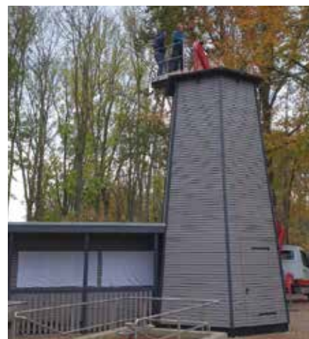
oben: Vor der Sanierung: Das Pumpenhäuschen war deutlich kleiner, das Holz stark angegriffen.
