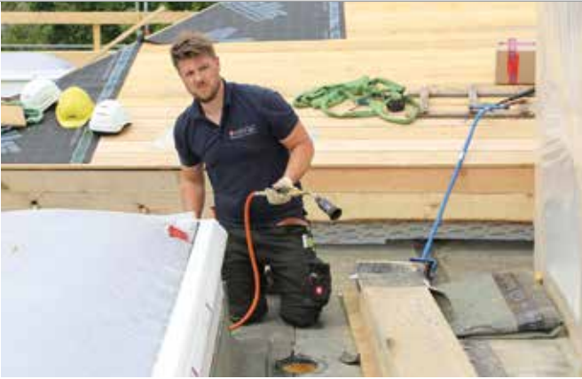
Knifflige Feinarbeiten für einen sehr speziellen Dachaufbau.
