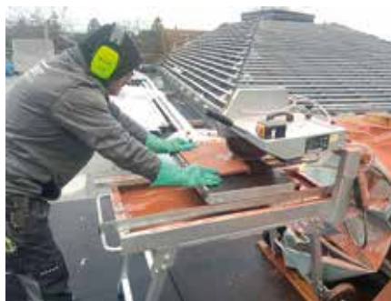
Zuschneiden der Tonziegel direkt vor Ort auf dem Dach.
