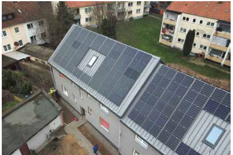
Auch Photovoltaikmodule können im Zuge der seriellen Sanierung direkt installiert werden.
