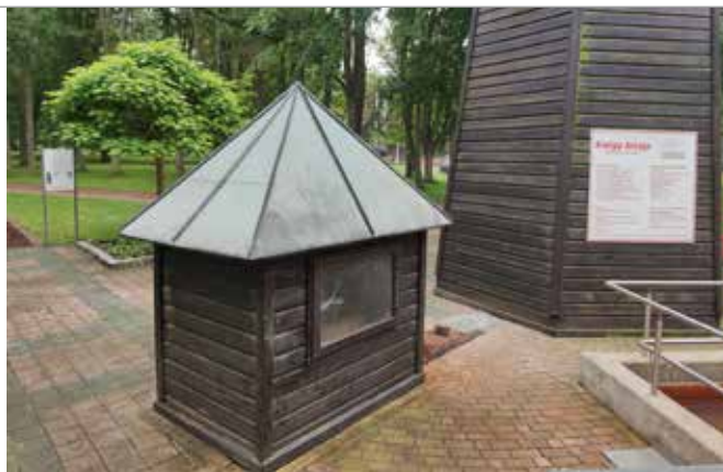
oben: Vor der Sanierung: Das Pumpenhäuschen war deutlich kleiner, das Holz stark angegriffen.
