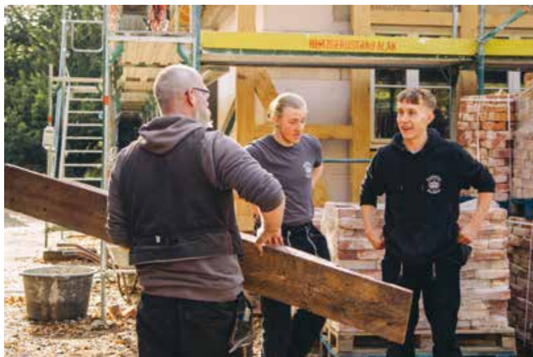
Von erfahrenen Gesellen auf den Baustellen lernen – die Azubis bei Hannover Dachbau erhalten zudem weiteren Praxisunterricht.
