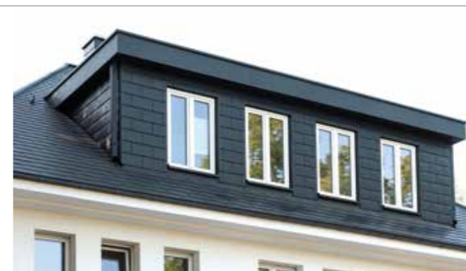
Zum Verkleiden der Dachgauben kam eine 4mm-Verbundplatte in derselben Optik wie die Schindel zum Einsatz.
