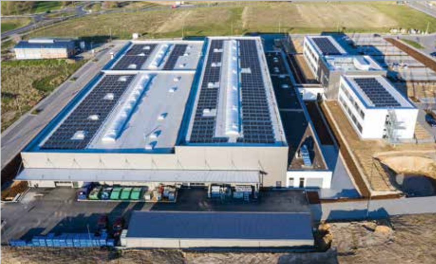
PV-Anlagen auf dem Flachdach macht das Team von Gebrüder Rückert bereits seit 2011.
