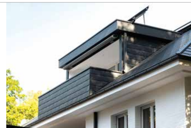
Zum Verkleiden der Dachgauben kam eine 4mm-Verbundplatte in derselben Optik wie die Schindel zum Einsatz.
