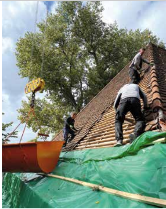
Die Modernisierung realisierte das Team mit Antik-Bibern.
