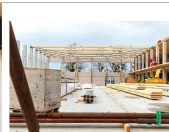
Eine Binderkonstruktion aus Holz bildet das Hallendach.
