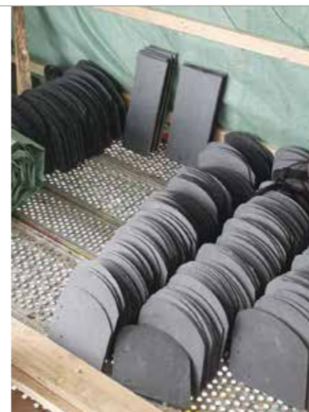
Das Material für die Schiefereindeckung liegt bereit.
