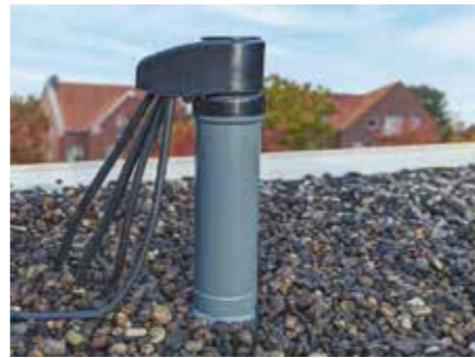
Mit dem Flachdach-Schwannenhals mit Klappenelement lassen sich Leitungen noch leichter wetterfest verlegen.
