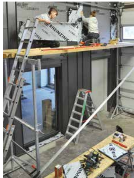
Azubiprojekt bei Hörnschemeyer: eine Wandverkleidung mit Tafelware aus Zink.
