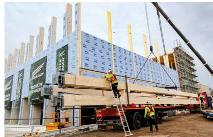
Die Holzwände stehen, jetzt wird das Dachtragwerk aufgesetzt.
