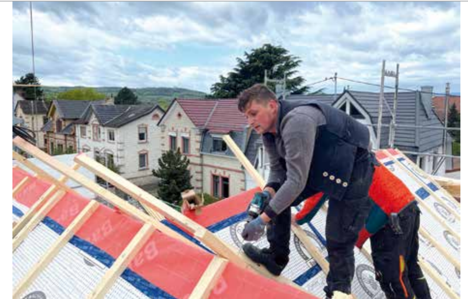
Mitarbeiter bei der energetischen Steildachsanieurung.
