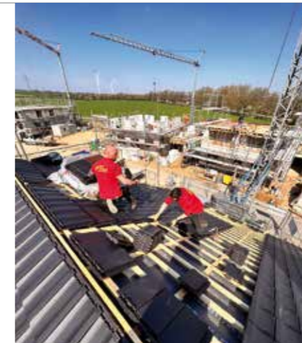
Die Motivation ist gestiegen, die Krankentage sind gesunken. Das Team des Betriebs Tim Evertz Dachdeckermeister will weiter vier Tage die Woche arbeiten.
