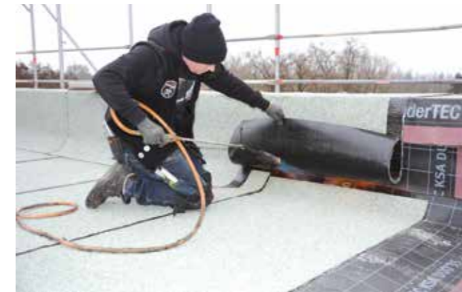
Schweißarbeiten auf dem Flachdach mit 2600 Quadratmeter Fläche der Oberschule Lerchenstraße in Bremen-Nord.
