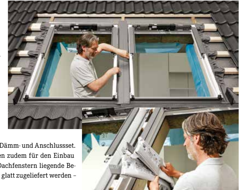
Die neue, patentierte Mittelrinne kann flexibel je nach Fensterabstand um maximal sechs Zentimeter bis an das rechte Fenster herangeschoben werden.
