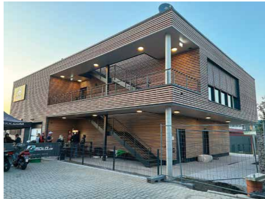
Neubau „Quartier am Sachsenring“ mit Räumen für eine Auto-Folierung sowie fünf Ferienappartements.
