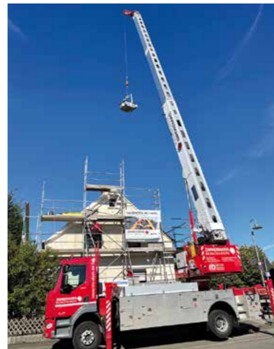
Das Material kommt mit dem firmeneigenen Kran aufs Dach.
