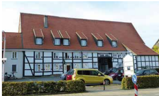
Der Betrieb hat das Steildach mitsamt Gauben des Fachwerkgebäudes und Baudenkmals Reginenstraße 16 in Hamm, erbaut in der Mitte des 19. Jahrhunderts, energetisch saniert.
