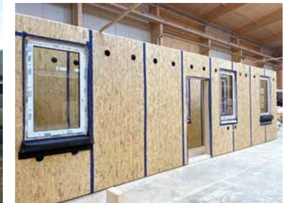
Holzmodulwände mit bereits integrierten Fenstern aus der eigenen Vorfertigung.
