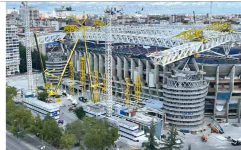
Eine Großbaustelle mitten in Madrid: Erneuerung von Dachkonstruktion und Fassade.
