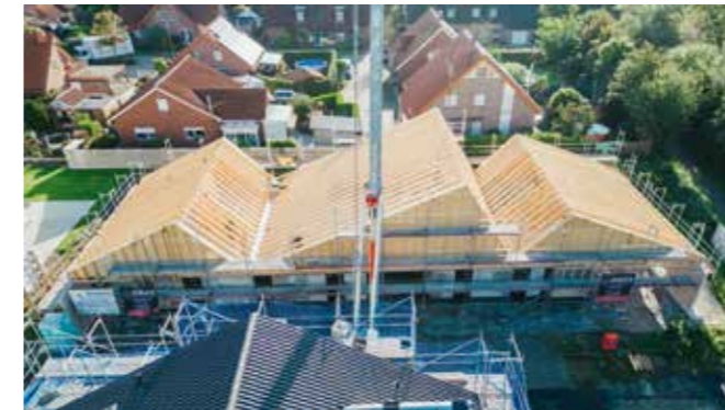
Ein neues Dachgeschoss realisiert in Holzbauweise als Sheddach mit unterschiedlichen Höhen.
