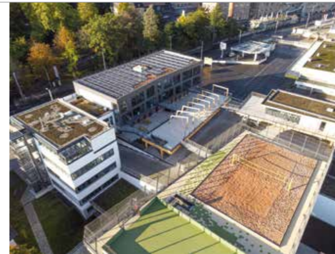
Der Business & Beach Campus in Würzburg vereint unterschiedlichste Flachdachnutzungen an einem Standort.
