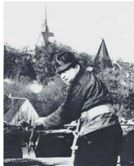
Schnappschuss aus der Historie: ein Mitarbeiter bei der Dachsanierung.
