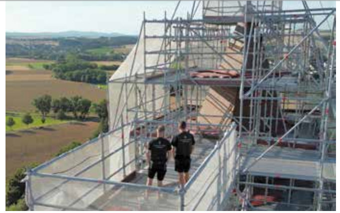
Bei so interessanten Projekten besteht kein Nachwuchsmangel für die Zimmerei Fuchs.
