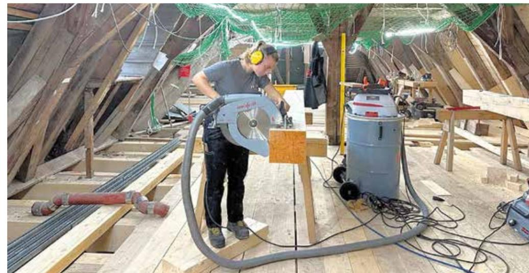
Sanierung des Dachstuhls vom Domberg in Freising. Theresa Damm bindet mit einer 130er Handkreissäge einen neuen Balken ab, der einen maroden ersetzt wird.
