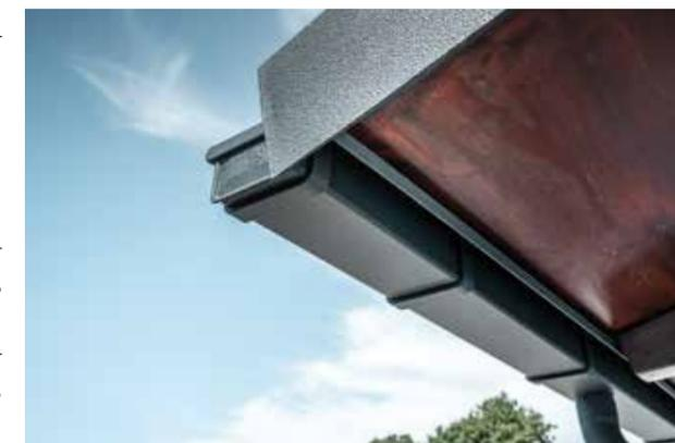
Schönes Detail: die vorgehängte, kastenförmige Dachrinne aus Aluminium.
