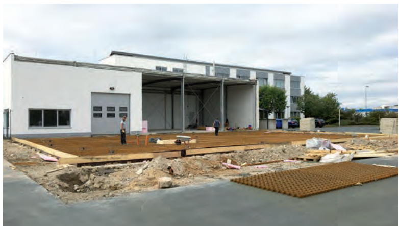
Bauarbeiten zur Bodenplattenerstellung
